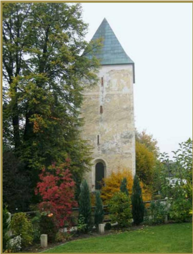
Spuren der romanischen Bauphase lassen sich noch an **Quadersteinen** im Unterbau des quadratischen Turmes und einem kleinen rundbogigen **Schlitzfenster** an der Ostseite des Turmes erkennen.
